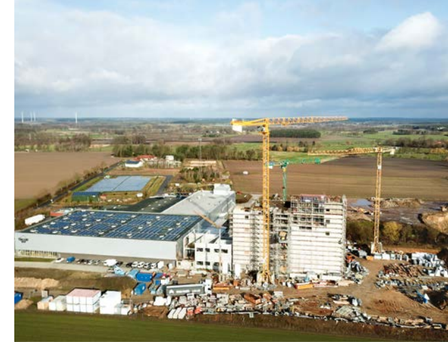
Im Spätsommer soll die neue Mühle in Betrieb gehen.
